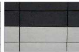
Lygus paviršius su liniuotomis vertikaliomis siūlėmis
